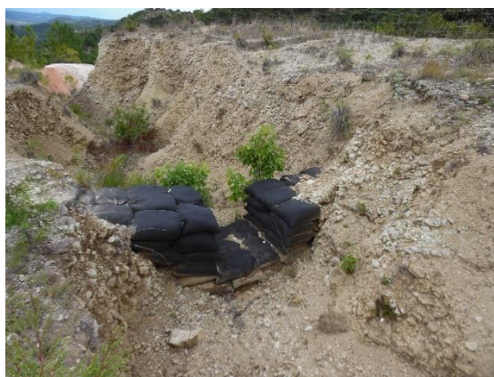
Figura 15. Presa de geocostales
