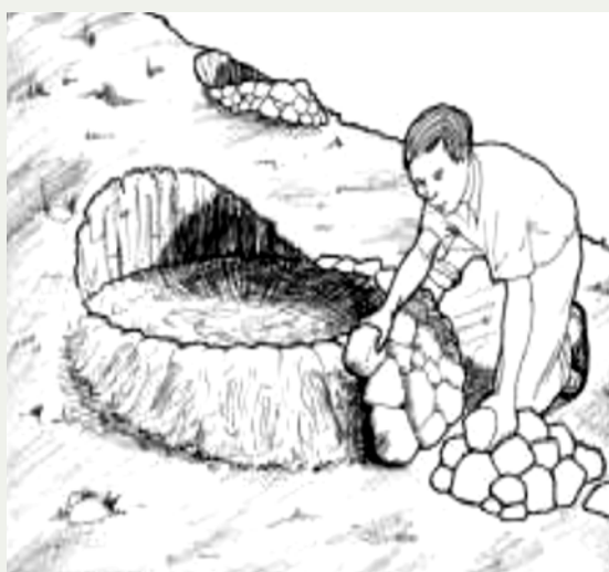
Figura 3. Construcción de bordo para captación de agua.
