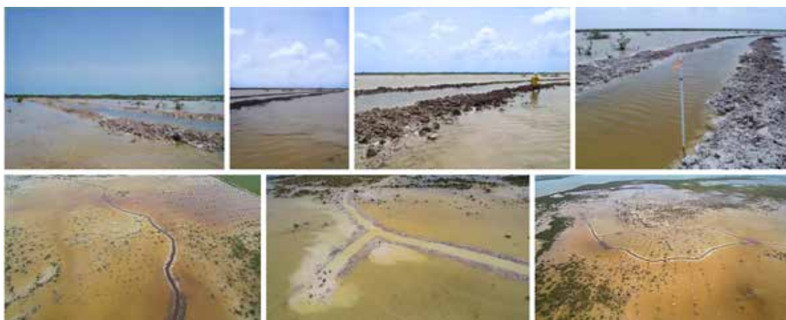
Figura 1. Restauración de canales secundarios (vista aérea de la zona) en 2015. Foto: Jorge Herrera-Silveira.
